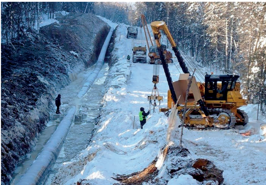
Рисунок 4. Траншейная укладка трубопровода в тяжелых условиях
