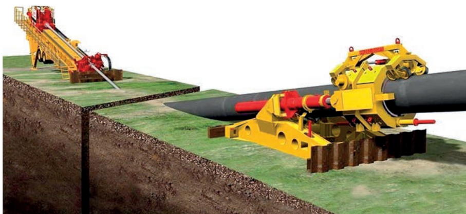
Рисунок 2. Применение доталкивателя при ГНБ [10]
